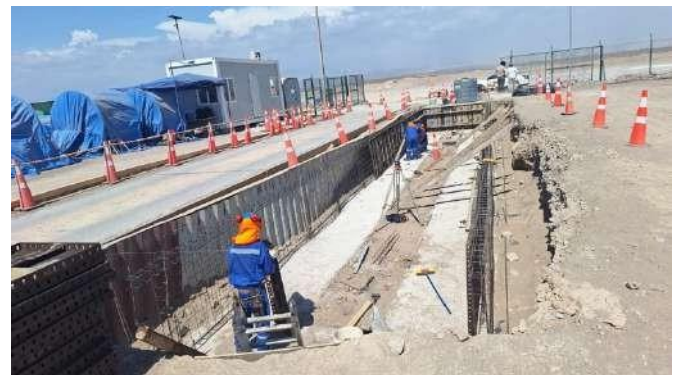
Enfierradura a muro
