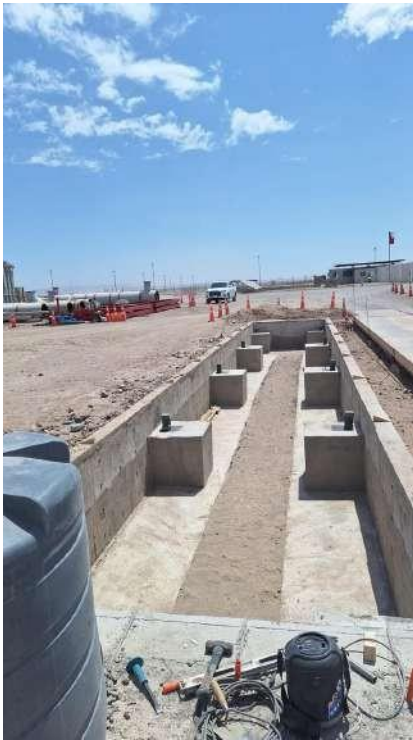
Foso con fundaciones listo para recibir módulos
