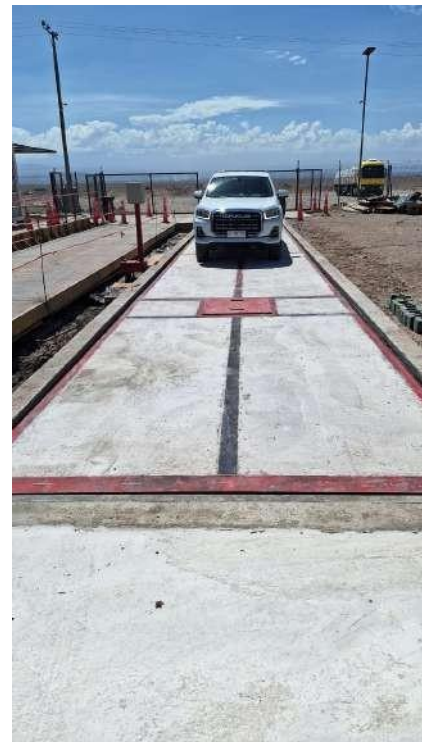
Limpieza marco y modulo (grateado) previa pintura
